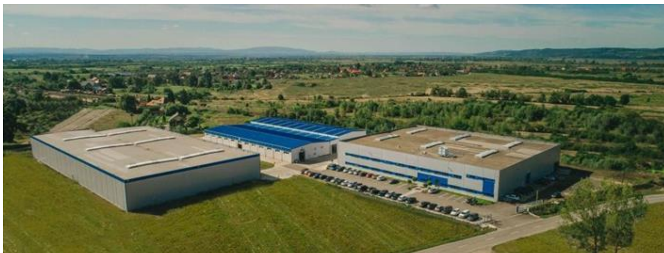
Delta Engineering à Baia Mare, Roumanie
